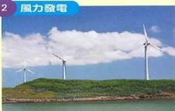
利用風力帶動風車葉片旋轉，推動發電機發電。
