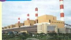
以煤、石油、天然氣等為燃料，將水加熱產生蒸氣來推動發電機發電。
