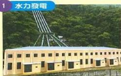
水從高處落下的能量，推動發電機發電。
