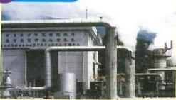
宜蘭縣清水地熱區屬變質岩區，當地的地下溫度較高，地下水受熱變成高溫蒸氣，利用高溫蒸氣推動發電機發電。
