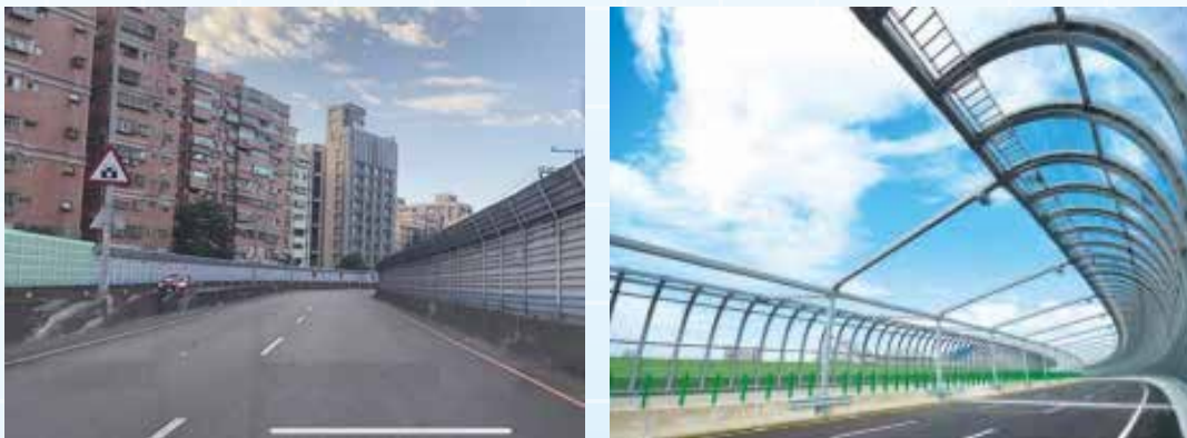
圖二 高速公路隔音牆（來源：聯合報 udn 聯合新聞網、FB: 建設大台中）
